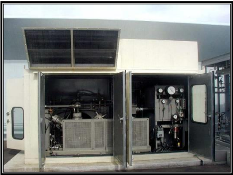
防音キャノピー施工写真
